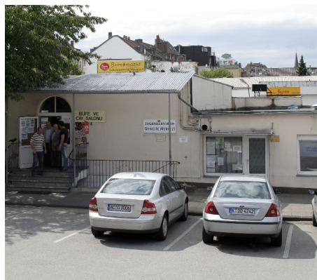
Abb. 2: Räume einer ehemaligen Gewerbeliegenschaft, die für Lebensmittelgeschäft, Teeraum und Jugendzentrum ungenutzt wurden, hier im Komplex der alten Kölner Zentralmoschee, 2007. © Uta Winterhager, Bonn.
