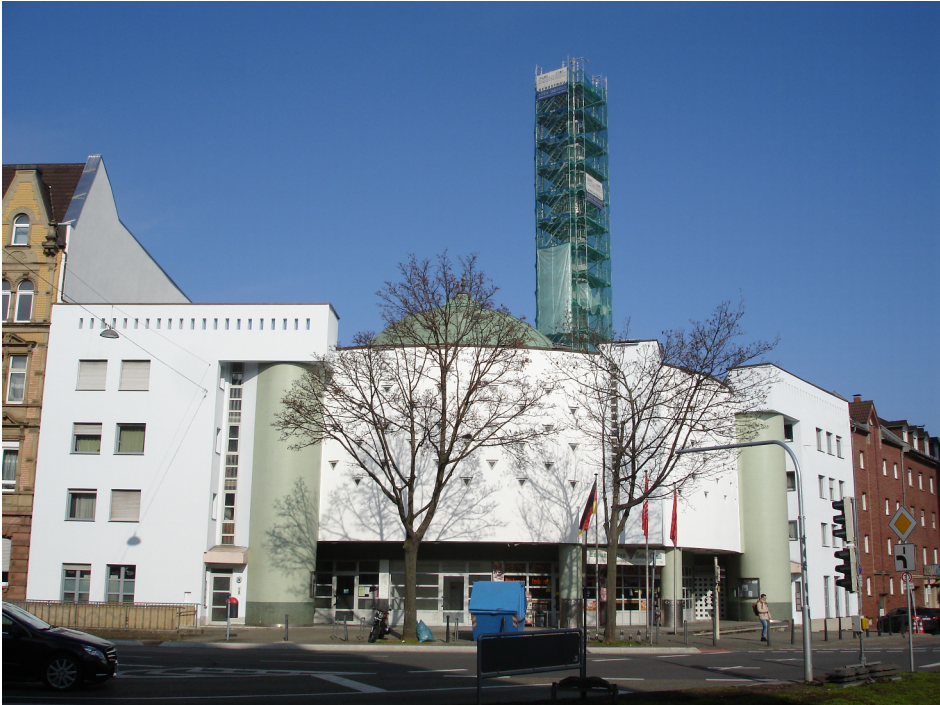
Abb. 3: Die Yavuz-Sultan-Selim-Moschee Mannheim von 1995, hier mit eingerüstetem Minarett, 2025. © Beate Löffler.
